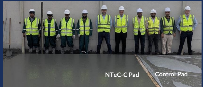
Successful Concrete Pour in KSA (Dec 2025)
